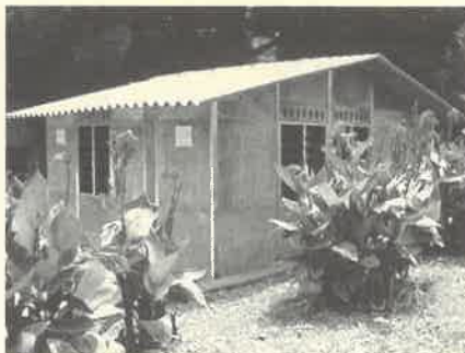
Imagen 6. Vivienda construida con paneles de concreto reciclado. Medellín, Antioquia. Los residuos industriales: el eco-cemento
