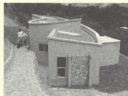
Imágenes 1 y 2. Vista general de una vivienda en suelo-cemento. Guarne, Antioquia.
