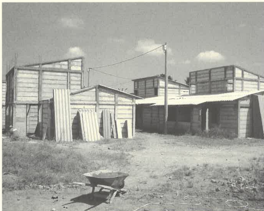
Imagen 7. Panorámica de instalación de prefabricados confeccionados con eco-cemento proveniente del reciclaje de cenizas volantes de hornos industriales. Palmira, Valle del Cauca.
