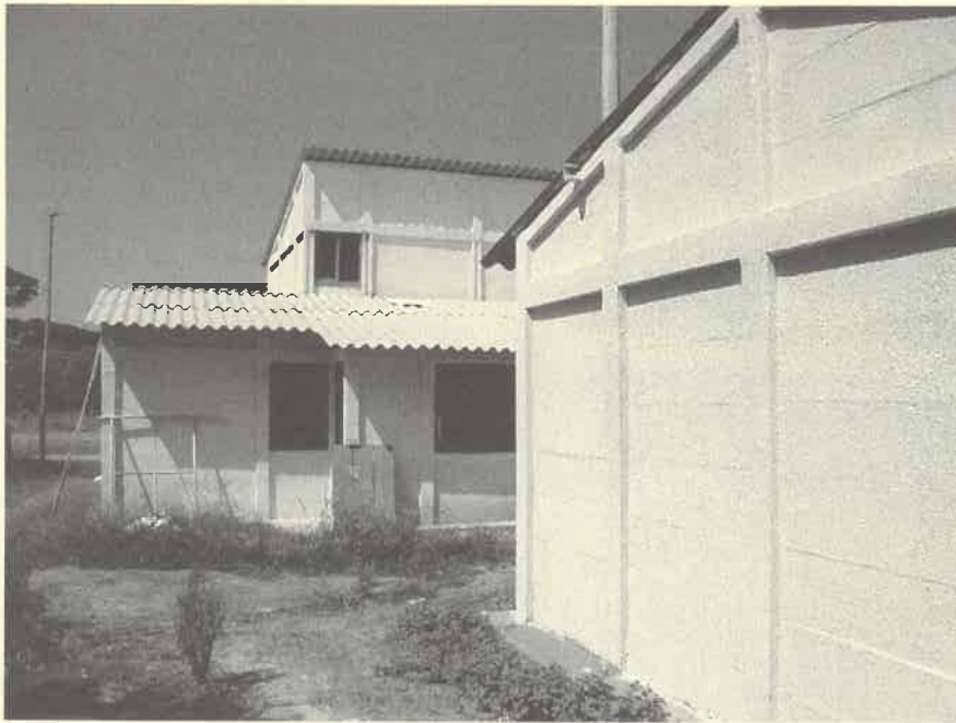
Imagen 8. VISS construida con eco-materiales; aprovechamiento de cenizas volantes, escoria de hornos siderúrgicos y cerámicas descartadas para conducciones eléctricas. Palmira, Valle del Cauca.
