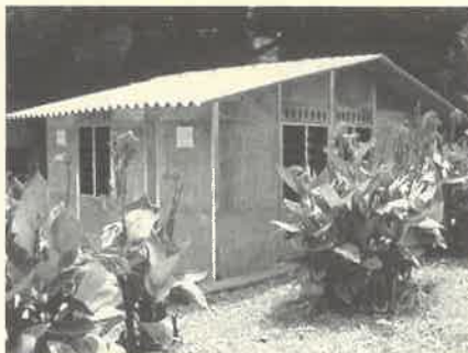
Imagen 6. Vivienda construida con paneles de concreto reciclado. Medellín, Antioquia. Los residuos industriales: el eco-cemento
