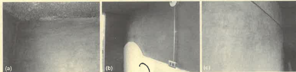
Figura 5. (a) Agrietamiento del pañete; (b) acabado del baño y (c) acabado del salón
