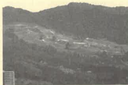
Fotos 4 y 5. Expansión urbana en suelo de protección. Zona sur-oriental del Valle de Aburrá.
