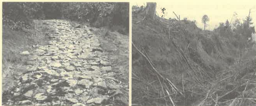
Figura 1. Izquierda. Camino prehispánico de Corrales, sale de Niquía hacia el cerro Quitasol, parcialmente restaurado, carece de obras de infraestructura que permitan su conservación. Su arquitectura original ha perdido majestuosidad. Derecha. Camino paralelo al de la figura 1, al norte, desde La Navarra hacia El Alto de Medina. Está enmarcado en la red de los caminos de arriería más importantes alrededor del Valle de Aburrá. Su vallado y empedrado ha sido alterado casi totalmente por las actividades agroindustriales. Parte del camino fue destruido por los procesos urbanizadores del sector. (Fotos tomadas por el autor)
