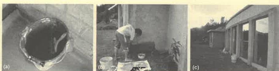
Figura 6. (a) Pintura roja elaborada con tierra; (b) aplicación de la pintura con brocha y (c) pintura de tierra roja aplicada en el exterior
