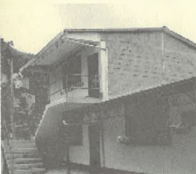
Escuela y placa deportiva, vereda Bramadora
