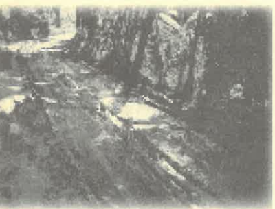
Ausencia de drenajes
